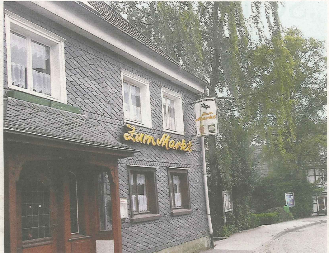
Hier kann nun wieder privat und auch öffentlich gefeiert werden. Katrin Müller und Heike Brandt stehen die renovierten Räumlichkeiten im neuen „Markt 57“ zur Verfügung.
